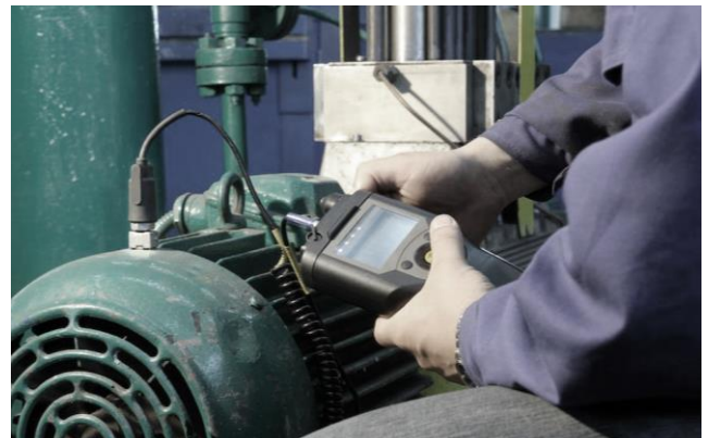
Figure 15 Acquisition de signal vibratoire à l'aide d'un analyseur de vibration
