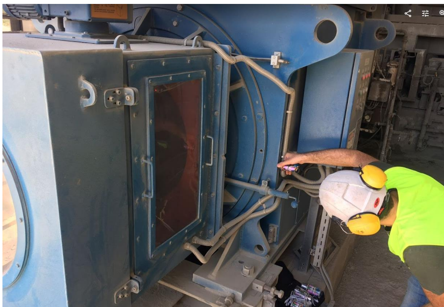
Figure 153 Machine étudié chez Cimenterie de Sibline
